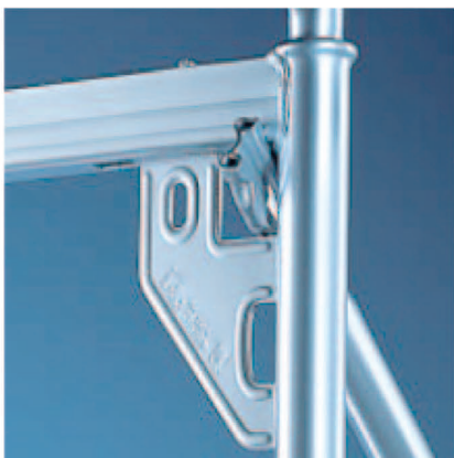
Кутові пластини на рамі призначені для діагональних зв'язків
